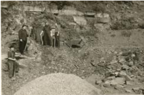
Frühjahr 1964: Beginn der Bauarbeiten
